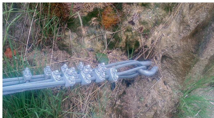
Узел крепления оттяжки кольцевой сетки динамического противоклападного ограждения энергоемкостью 500 кДж непосредственно в горную породу (глубина заделки анкера 1500 мм)
