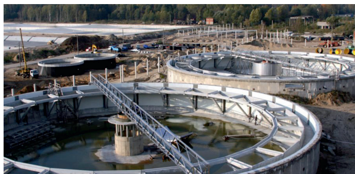
Реконструкция, профилактический и капитальный ремонт очистных сооружений (эксплуатация металлоконструкций в условиях агрессивных сред)
