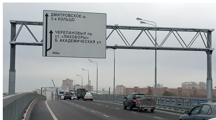
Монтаж конструкций щитов информационного обеспечения автодороги Москва – Санкт-Петербург (Северная Рокда, Москва, 2018 г.)
